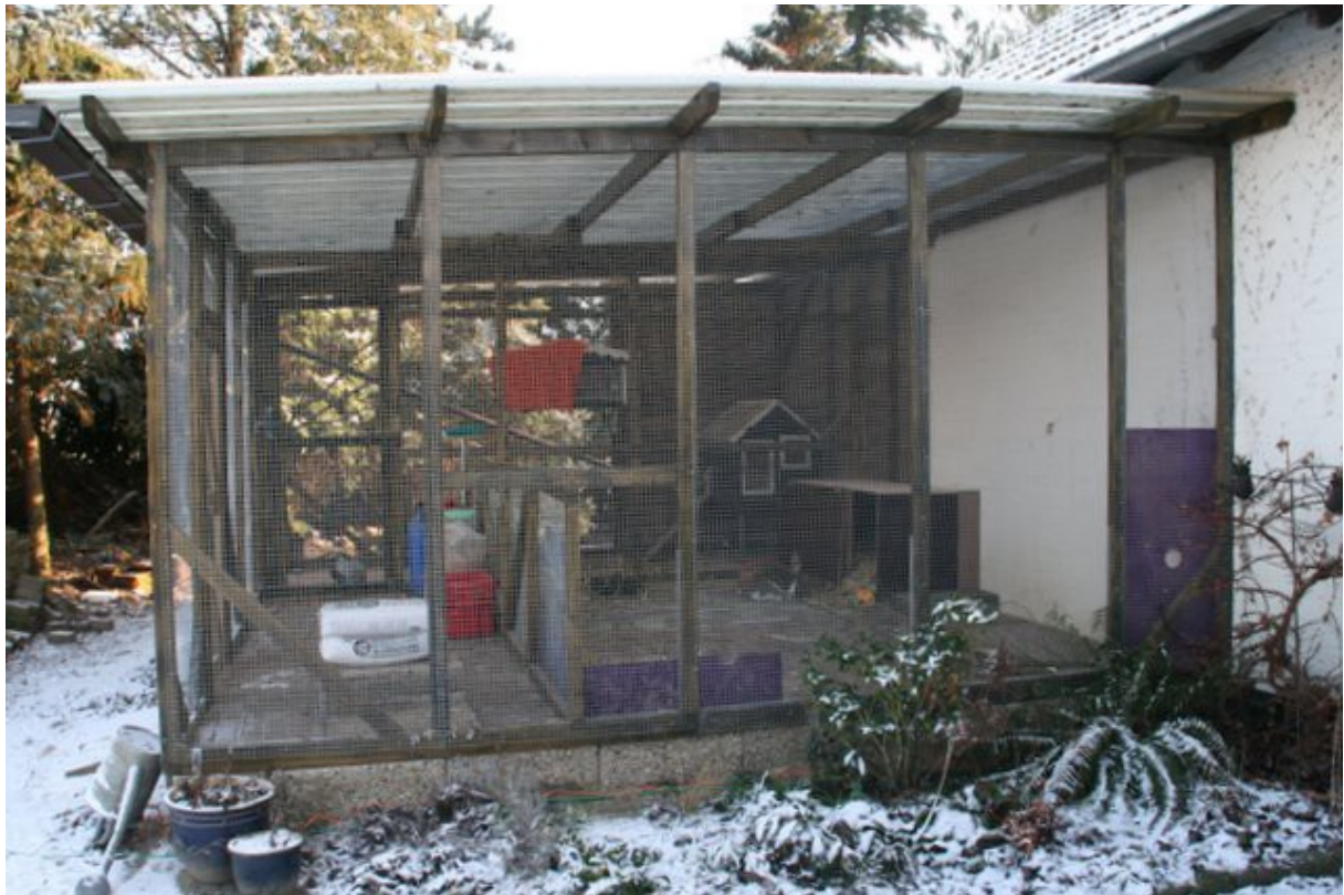
Foto 1: hier zie je dat het dak uitsteekt en schuin naar achteren afloopt. Er is fijn gaas gebuikt.
